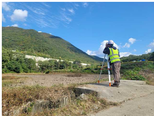
광파기를 이용한 측량 작업
