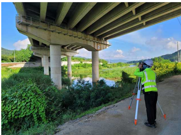
광파기를 이용한 측량 작업
