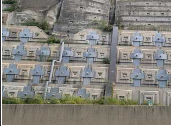
배수관, 배수로 전경
