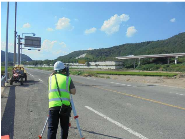
광파기를 이용한 측량 작업
