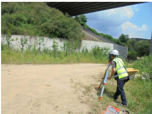
광파기를 이용한 측량 작업
