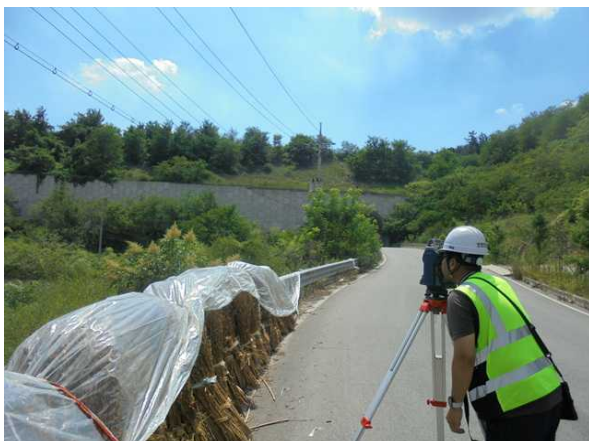
광파기를 이용한 측량 작업
