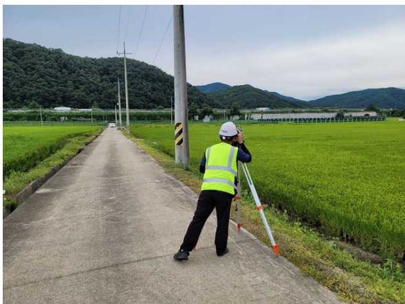
광파기를 이용한 측량 작업
