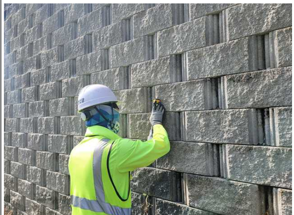
경사계를 이용한 경사도 측정
