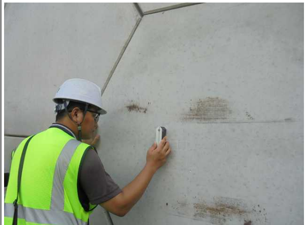
경사계를 이용한 경사도 측정
