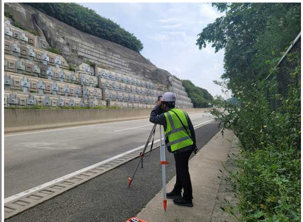
광파기를 이용한 경사도 측정
