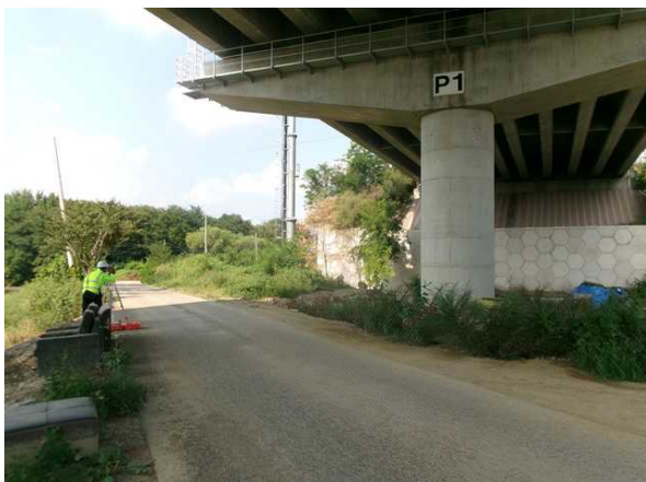
광파기를 이용한 측량 작업
