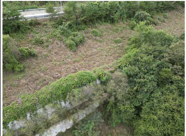
상부 성토부 전경
