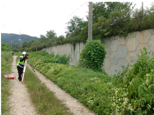
광파기를 이용한 측량 작업
