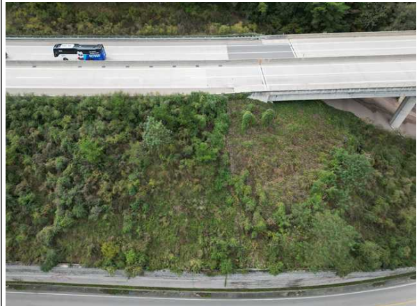
상부 성토부 전경
