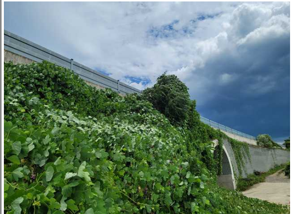
상부 성토부 전경
