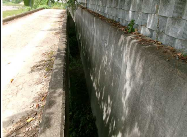
하부 배수로 전경
