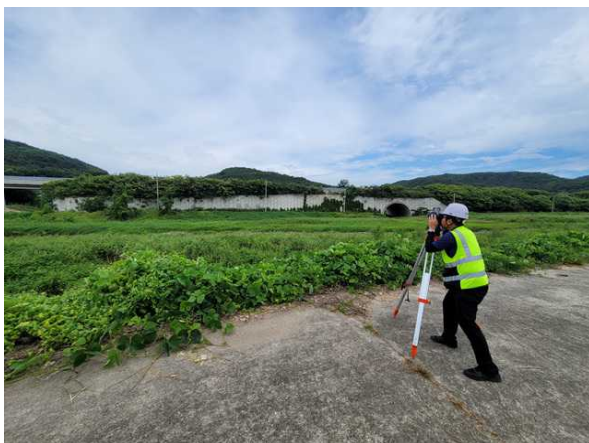
광파기를 이용한 측량 작업
