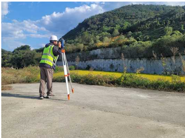
광파기를 이용한 측량 작업
