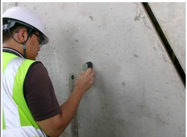
경사계를 이용한 경사도 측정
