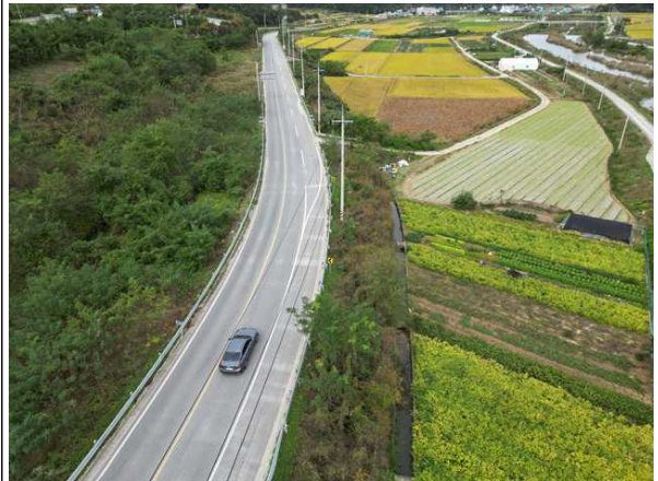
상부 성토부 전경
