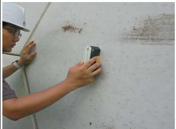
경사계를 이용한 경사도 측정
