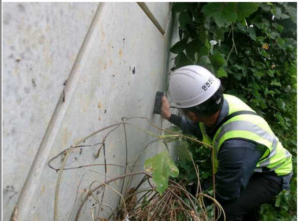
경사계를 이용한 경사도 측정
