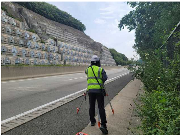
광파기를 이용한 측량 작업
