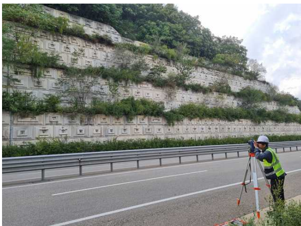
광파기를 이용한 측량 작업
