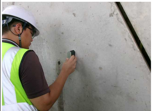
경사계를 이용한 경사도 측정
