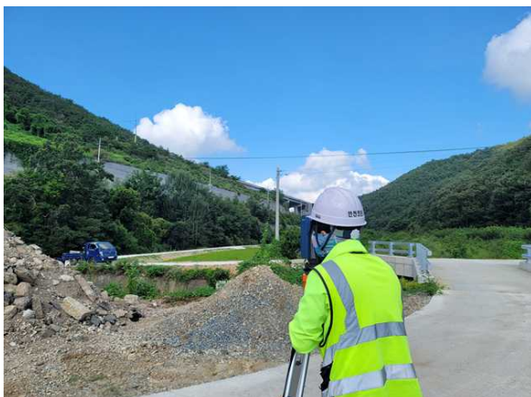
광파기를 이용한 측량 작업
