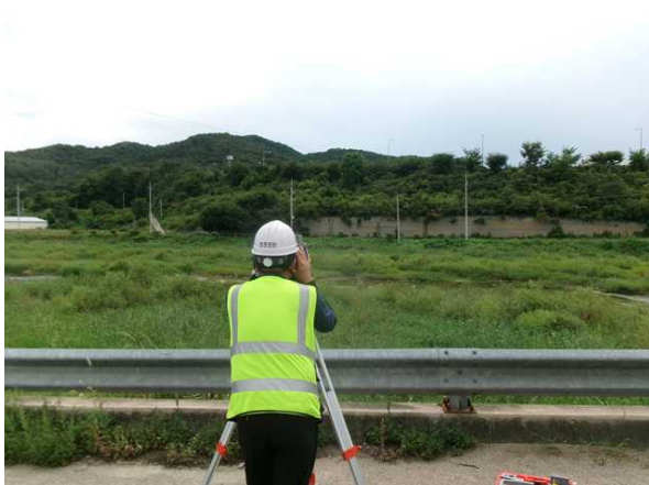
광파기를 이용한 측량 작업
