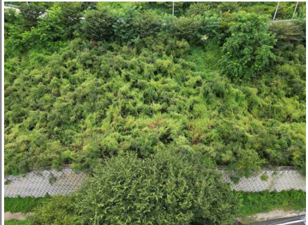
상부 성토부 전경
