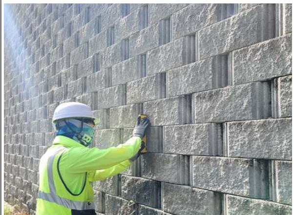
경사계를 이용한 경사도 측정
