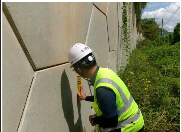
경사계를 이용한 경사도 측정
